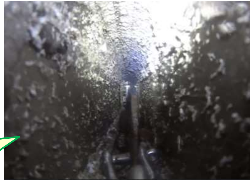
孔の拡大後の孔内部 16
