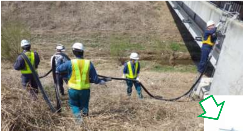
真空引きした後、先導ワイヤに接続
