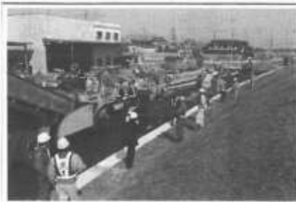
当日は、下りランプの延長190mを舗装した
