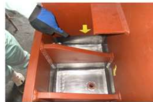
チタン箱施工状況
