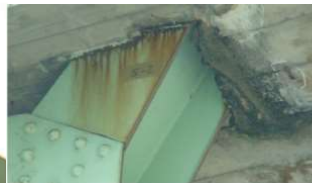
コンクリート埋設部
