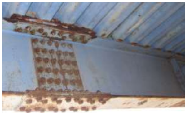
継手部 (高力ボルトまわり)
