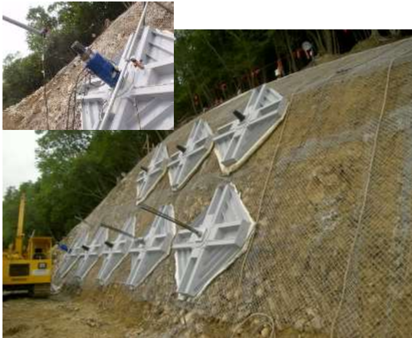
施工時に設置
