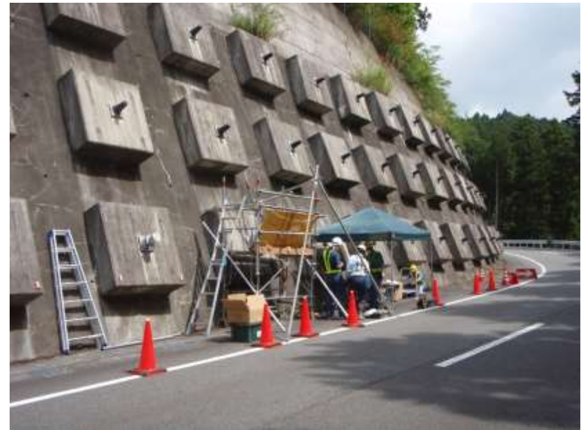
施工後に設置
