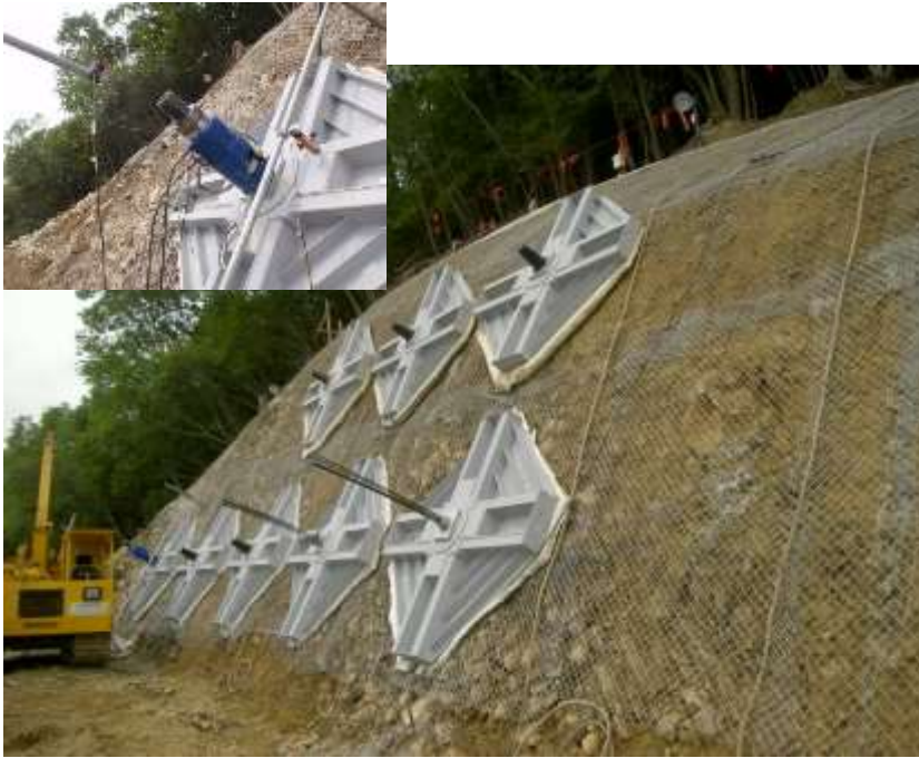
施工時に設置
