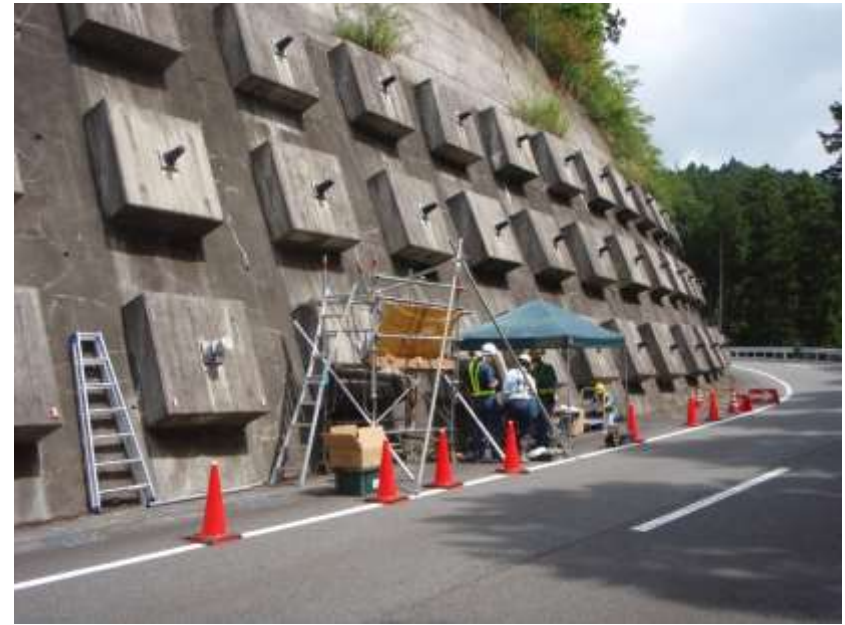
施工後に設置
