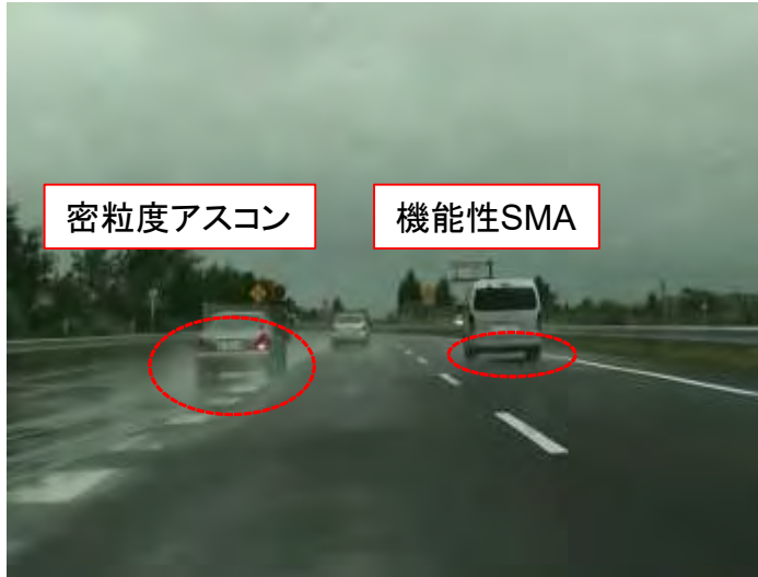
走行車の水けむりの比較 (密粒度アスコンと機能性SMA)
