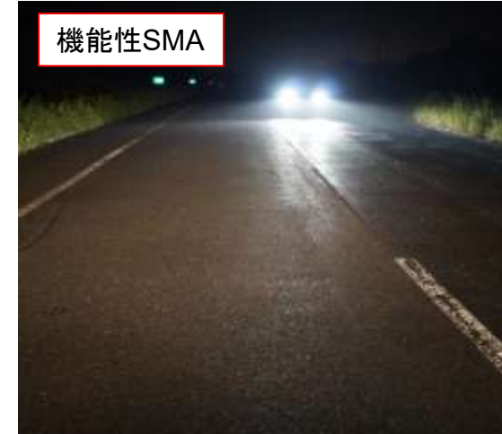
対向車ヘッドライトの路面反射光の比較 (密粒度アスコンと機能性SMA)
