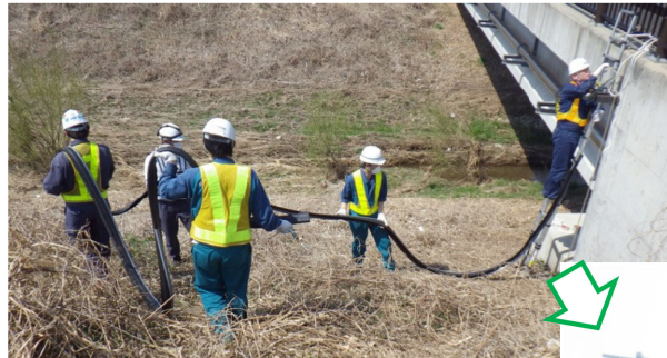
真空引きした後、 先導ワイヤに接続
