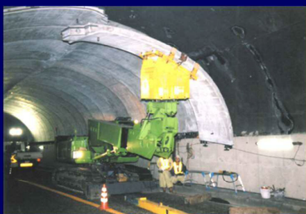
①施工写真
