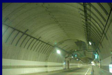
②完成写真
