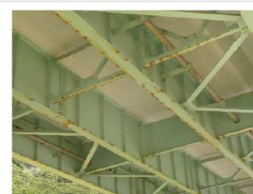
施工後1年3ヶ月
