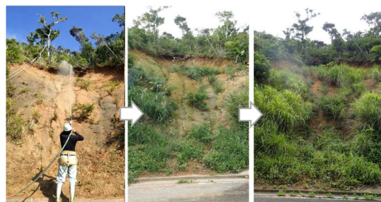
施工日 3か月後 9か月後 ※特に環境配慮が必要な現場
