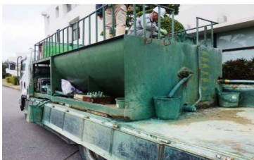
吹付工用ポンプ車
