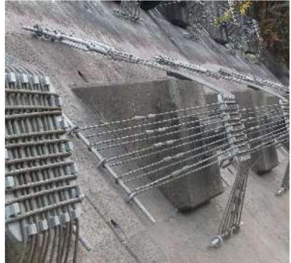
後施工アンカー+ワイヤー+鋼板
