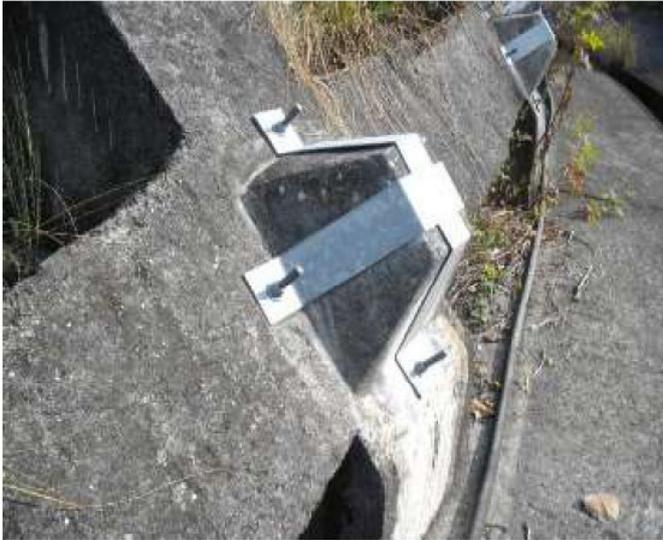
後施工アンカー+帯鋼板
