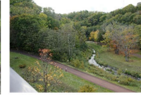
⑦高架橋上
