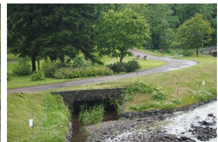
⑤小橋梁の架設位置
