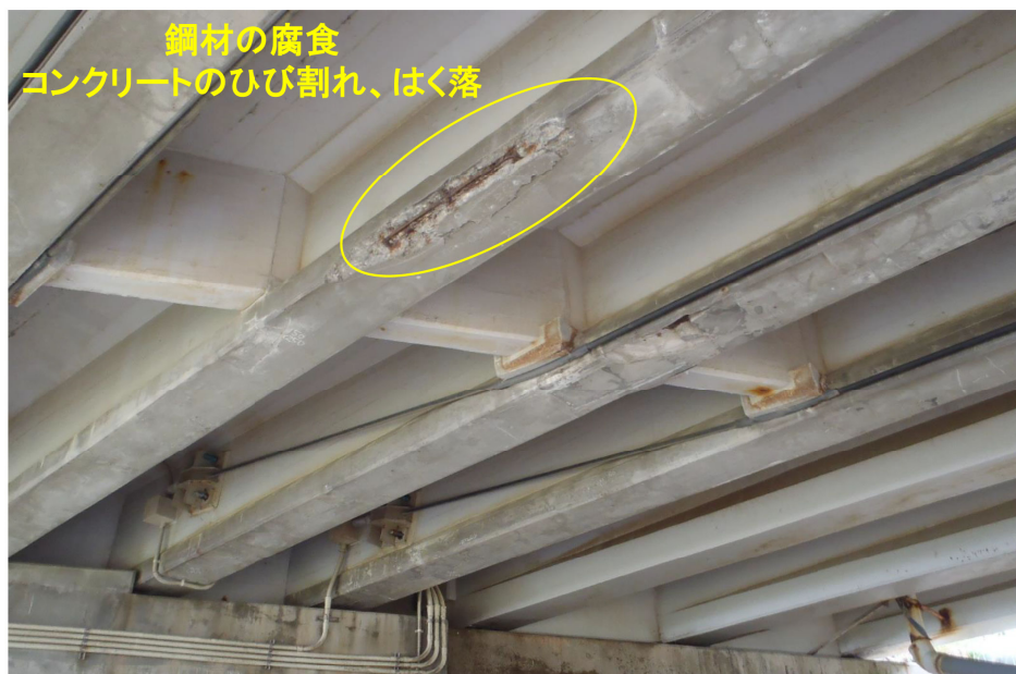
塩害地域の橋梁の例
