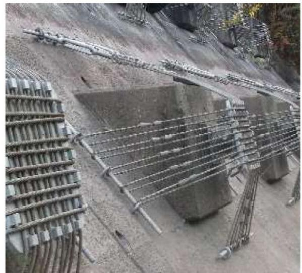
後施工アンカー+ワイヤー+鋼板
