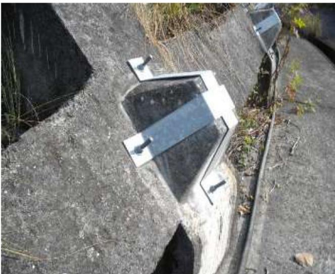
後施工アンカー+帯鋼板
