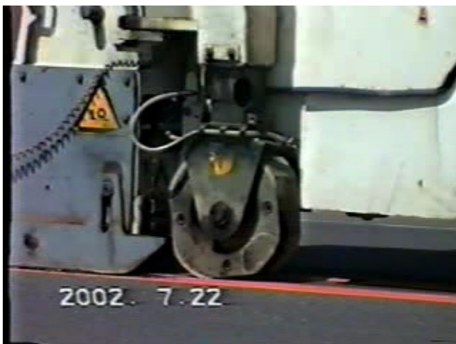
専用施工機械による施工状況
