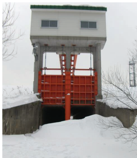
▲ 樋門設備全景（冬期間）
