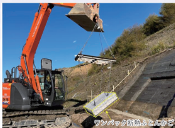
ワンバック断熱ふとんかごの設置の様子
