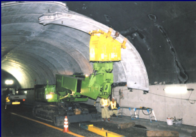
①施工写真
