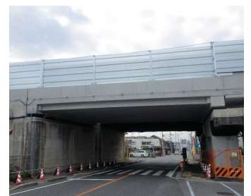
中国自動車道福岡新高架橋 写真提供：（一社）プレストレスト・コンクリート建設業協会
