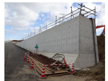
新名神高速道路 神戸ジャンクション東工事 写真提供：（株）大林組
