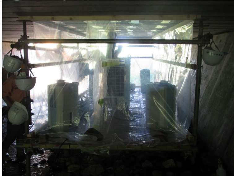
作業空間内に除湿機をいくつか設置 (除湿能力0.54ℓ/h/m 3 )
