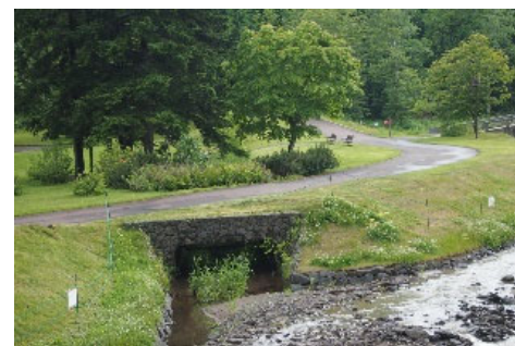
⑤ 小橋梁の架設位置
