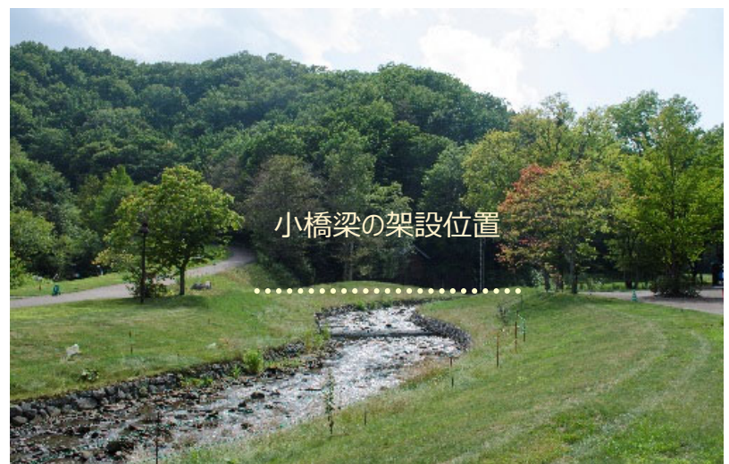
▲モデルケース（小橋梁の架設）
