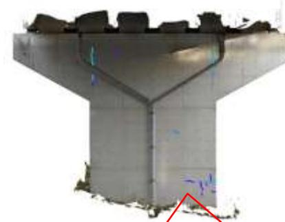
ひび検によるひびわれ自動検出例
