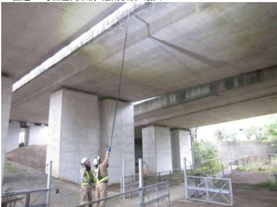
桁下に車両が乗り入れできない箇所など、直轄の橋梁点検でも活用しています。
