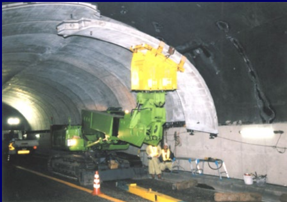
①施工写真
