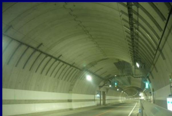
②完成写真
