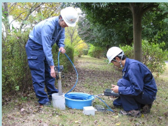
孔内傾斜計の測定状況
