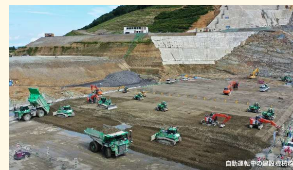
成瀬ダム（鹿島建設）
