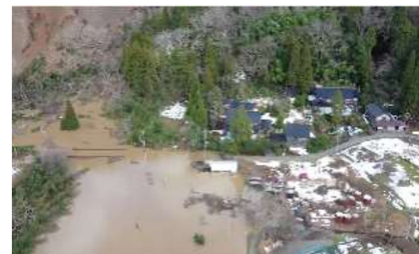
能登半島地震 (R6.1, 1) (石川県輪島市)TEC-FORCE撮影
