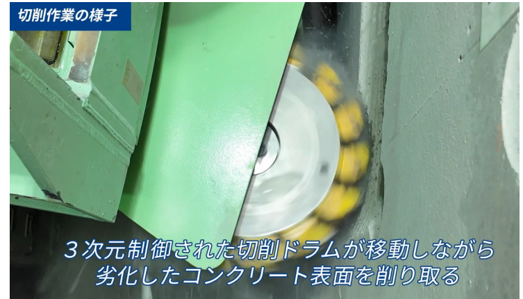
ドラムによる切削状況
