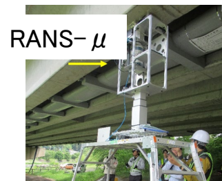
群馬県新三原大橋での計測
