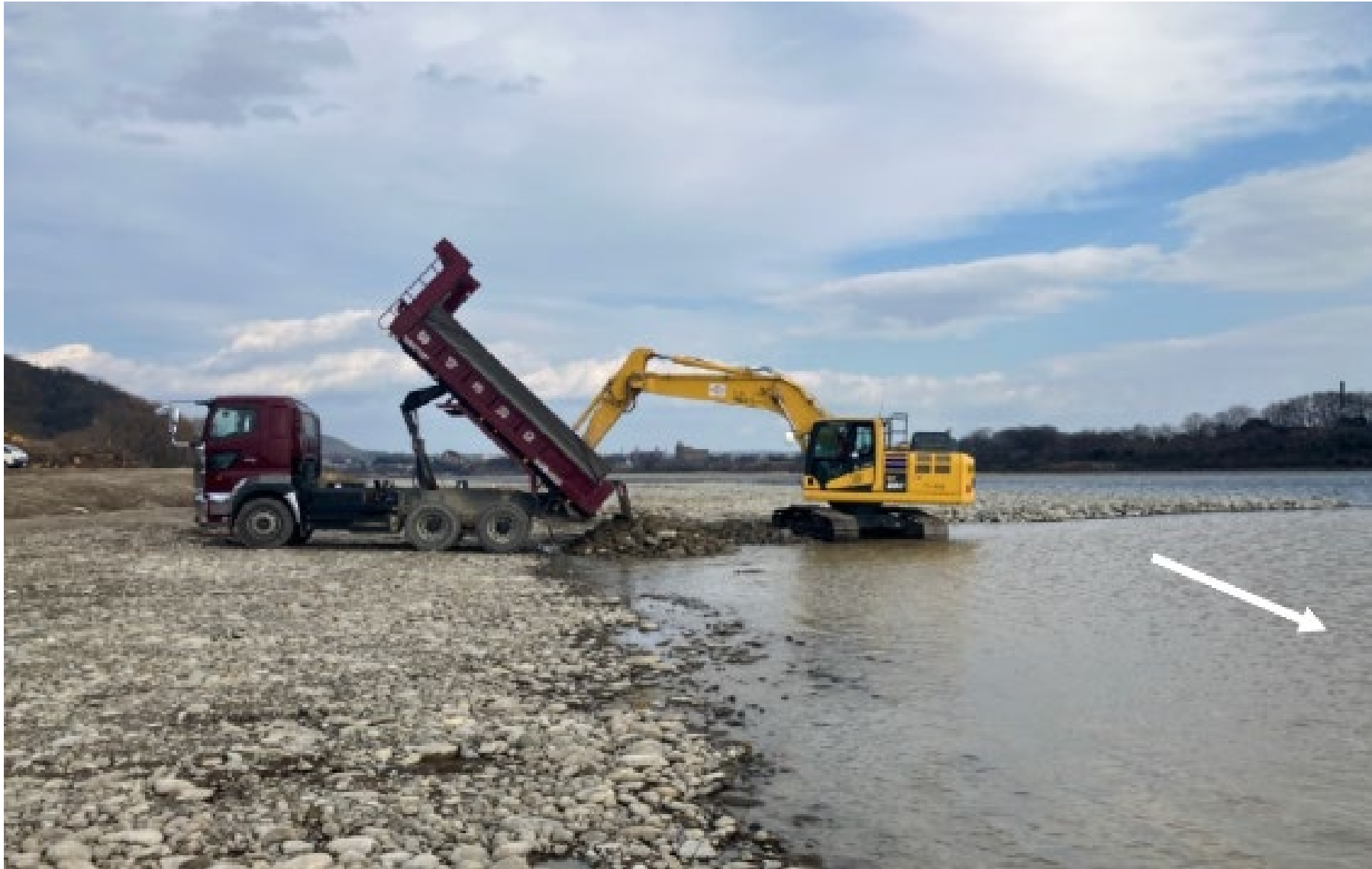
図3.10 木曽川54.6 kp右岸付近での玉石の投入 (2024年1月)
