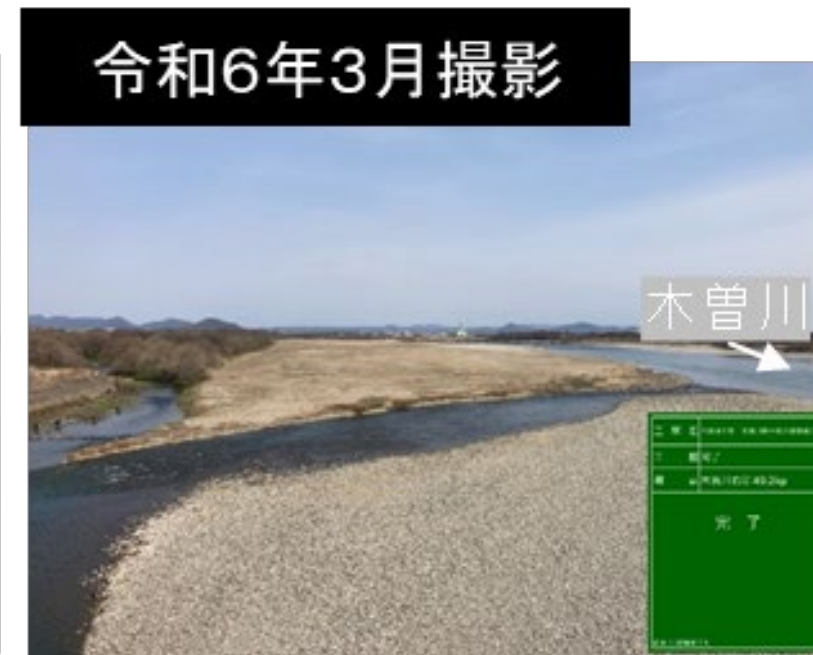
図3.9 木曽川における河道の二極化対策の試行の樹木群伐開例
