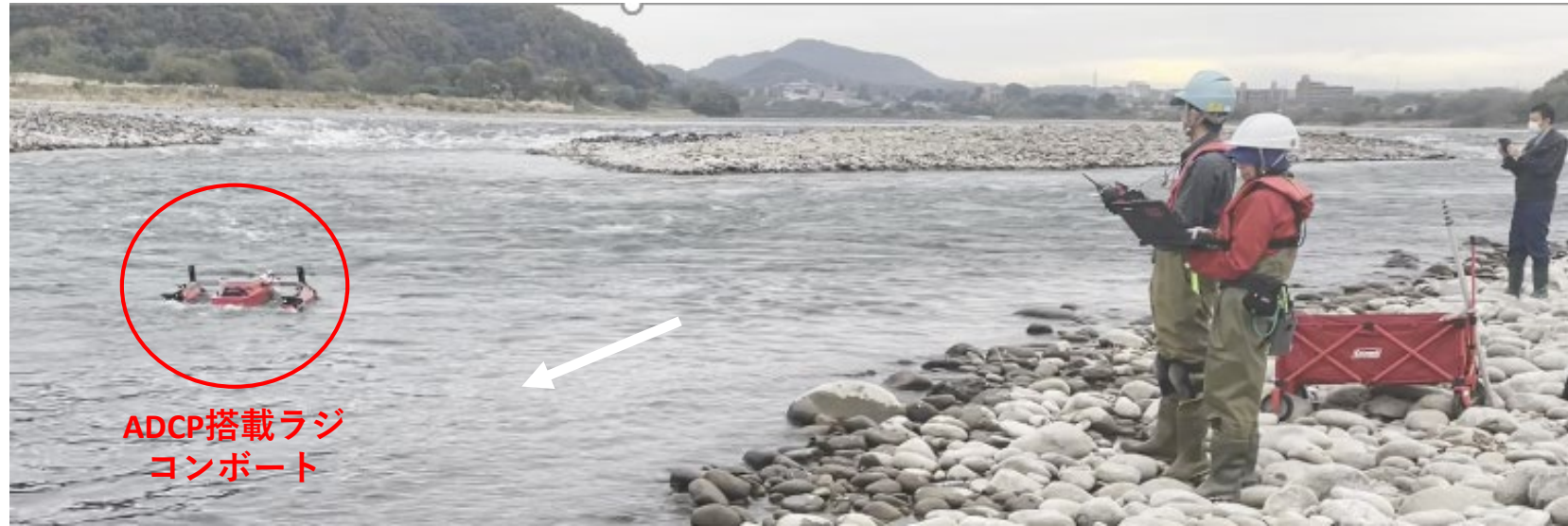
ラジコンボート搭載ADCPによる滞筋河床高計測風景
