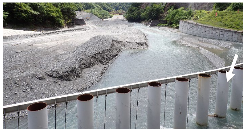
図4.7 土砂バイパストンネル呑口上流の堆砂（2023年）
