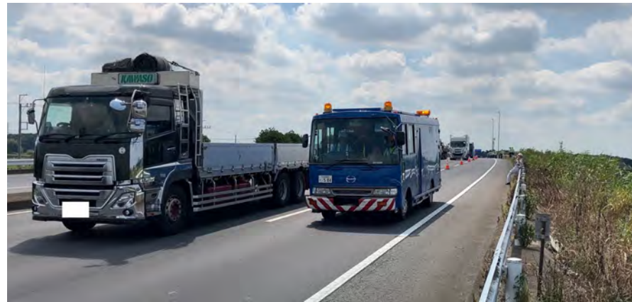
関東地整管内の直轄国道において実施した舗装点検の状況
