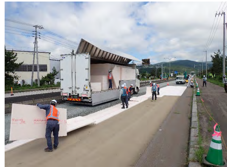
断熱材の施工状況
