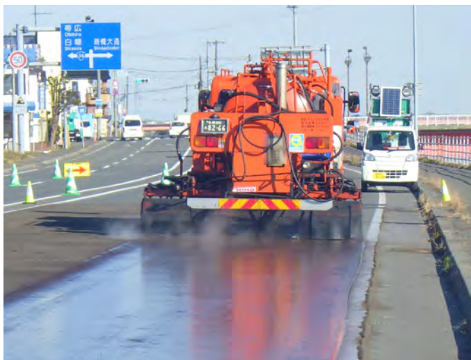
シール材、 Fog Seal による 融雪水の浸入軽減
