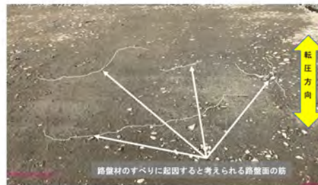
写真-2 路盤状況 (路盤厚 t=15cm)
