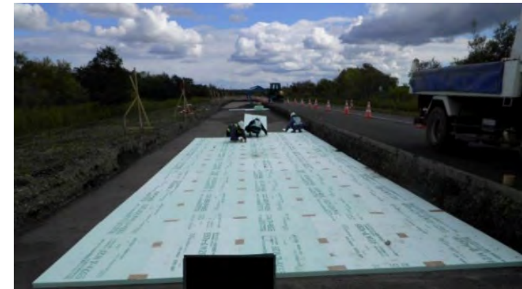
断熱材の設置の様子 (苫小牧寒地試験道路)
