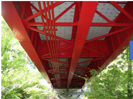
炭素繊維による補修
