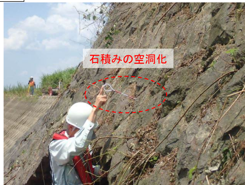
▲ 植生撤去後の被災箇所
