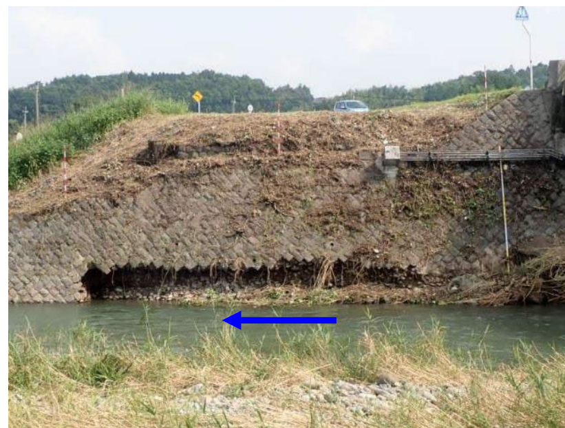
▲ 植生撤去後の被災箇所
