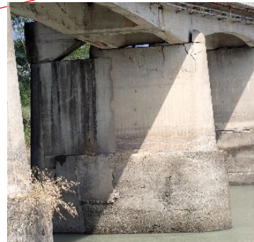
洗掘による沈下発生
