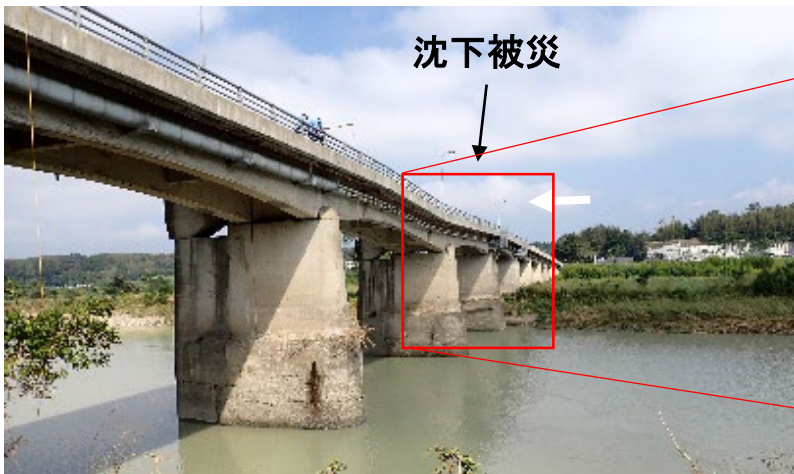
洗掘による沈下発生
