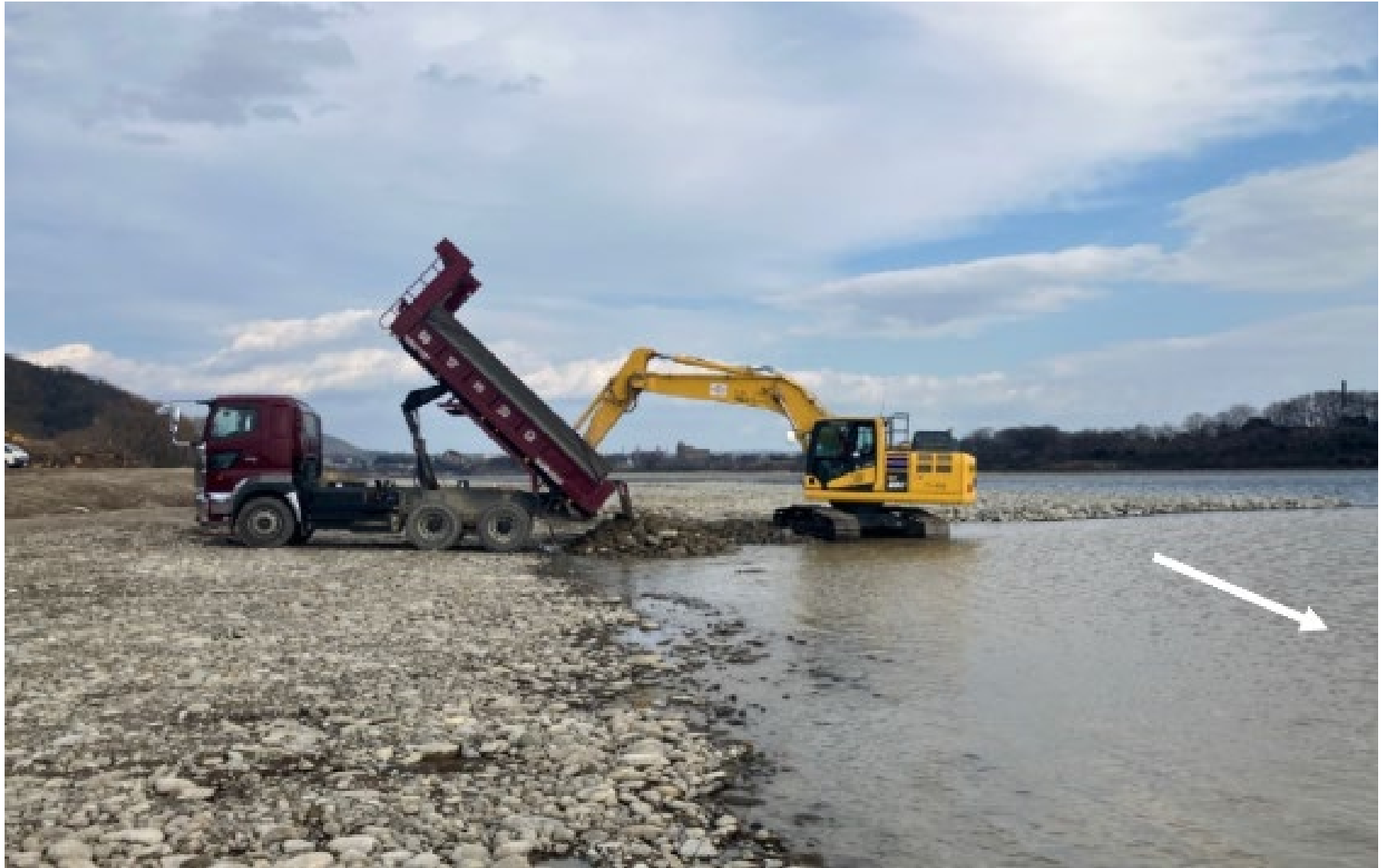
※木曽川上流河川事務所資料に追記 木曽川54.6 kp右岸付近での玉石の投入（2024年1月）
