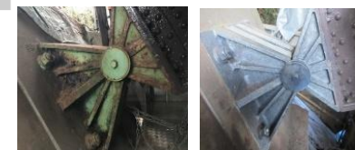
従来技術では施工困難だった部位のレーザー照射による処理例
