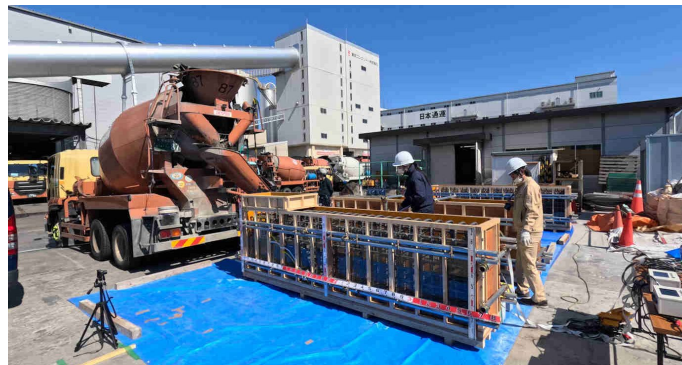
施工試験の状況
