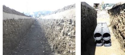
▲ 掘削断面及び管路敷設
