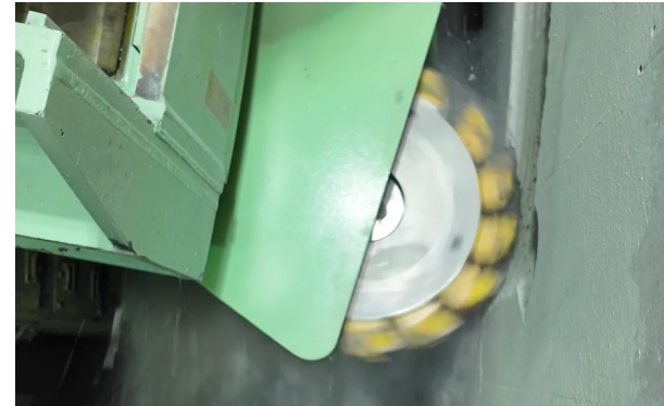
ドラムによる切削状況
