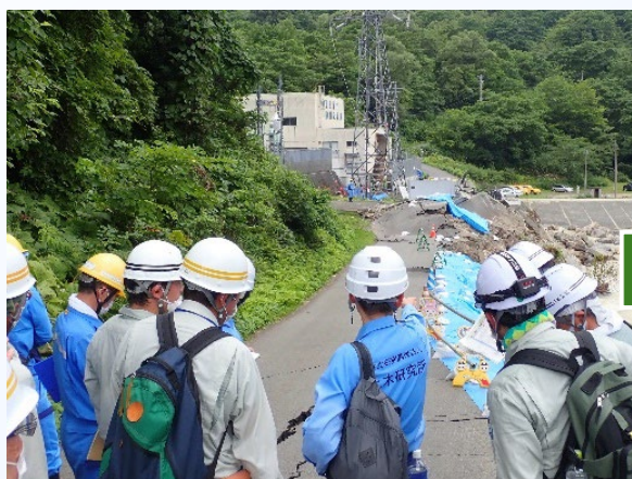
緊急的な現地調査
