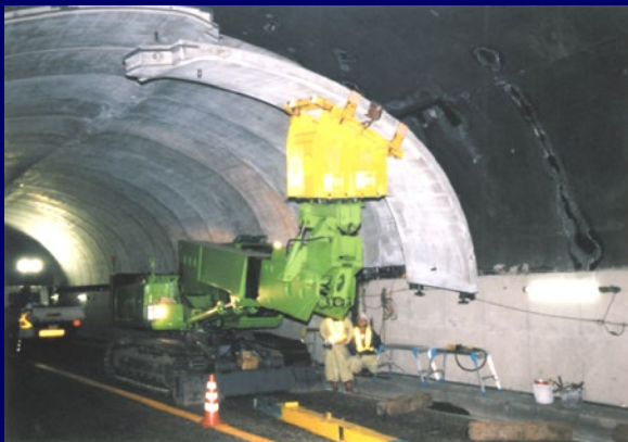
①施工写真
