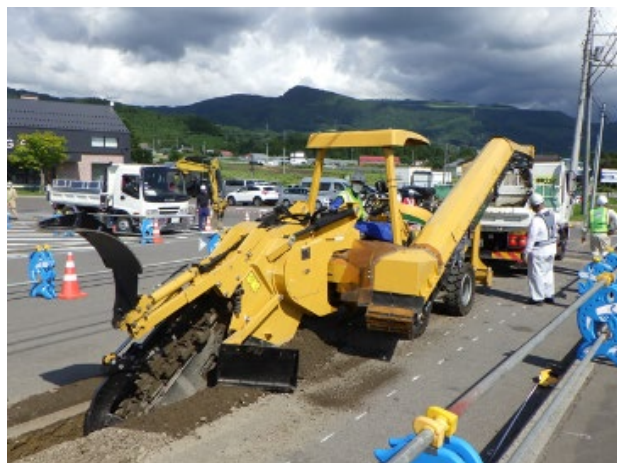
▲ トレンチャー工法による施工事例 (国道5号 赤松街道電線共同溝工事)
