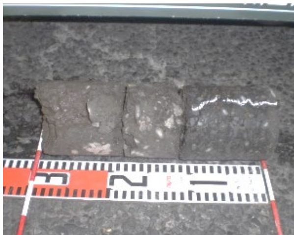
コア抜き調査
