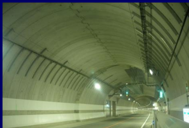
②完成写真
