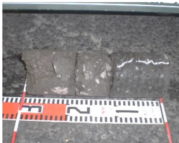
コア抜き調査
