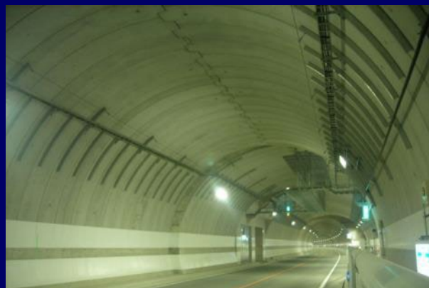
②完成写真
