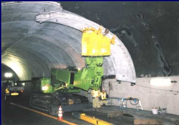
①施工写真
