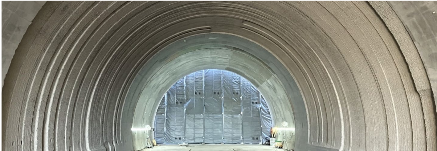
試験切削した覆エコンクリートの様子
