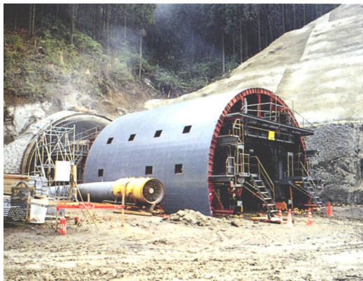
移動式型枠(セントル)
