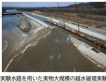
千代田実験水路を用いた実物大規模の越水破壊実験
