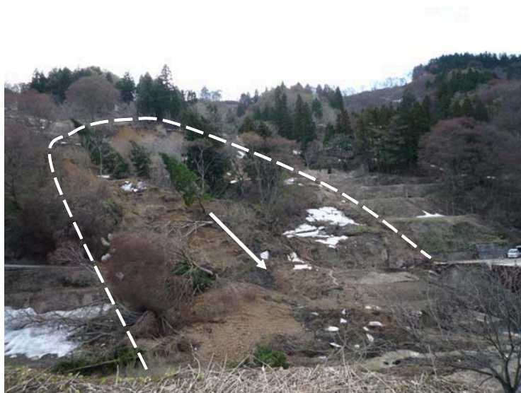
新潟県妙高市平丸 花立地すべり 幅90m 長さ130m
