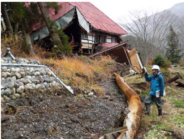
八方岩地区での地すべり
