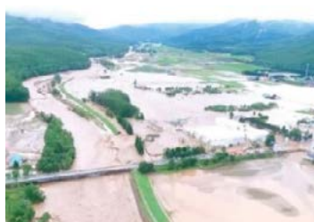
石狩川水系空知川堤防の決壊
