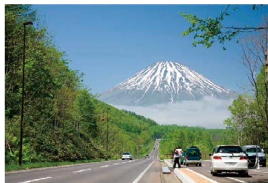
景観性や利用価値の向上により、多様なニーズに応える郊外部の道路空間の整備
