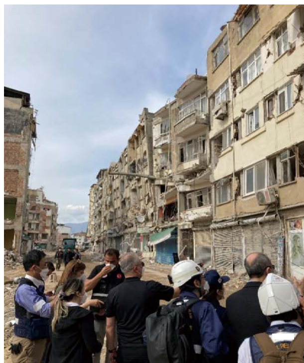
軟弱な地盤上の建物の被災調査（提供 JICA）
