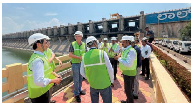
クリシュナ川アルマッティダムの現地調査
