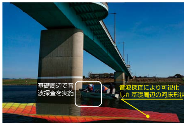
予防保全型メンテナンス技術の試行例 (基礎洗掘の状態を把握するための水中部の可視化技術)
