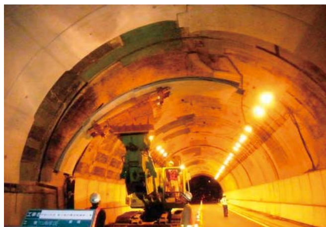
トンネルの内巻補強工の適用事例
