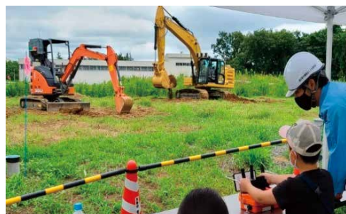
危険な現場で安全に建設作業ができる遠隔操作技術を体験してもらう
