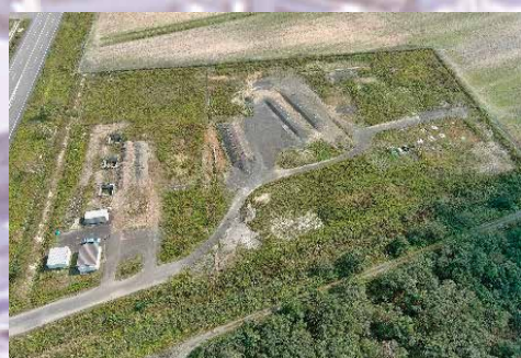
苫小牧施工試験フィールド
