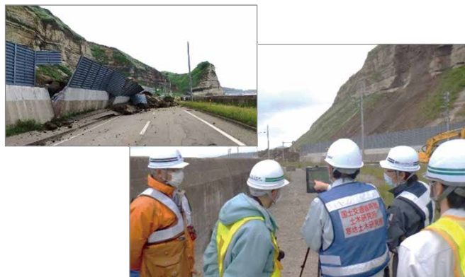
令和3年6月 国道229号の岩盤崩壊： 道路管理者との現地打合せ状況
