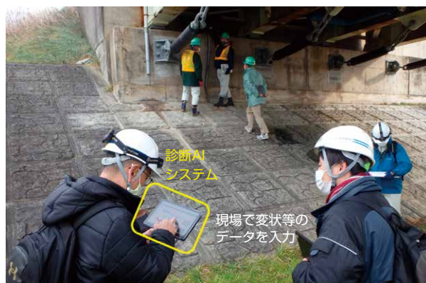
AIを活用した診断技術の試行情例 (橋梁診断支援AIシステム)
