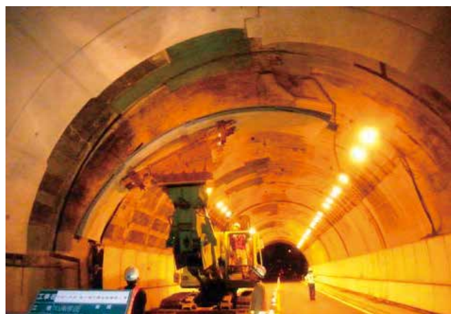
トンネルの内巻補強工の適用事例
