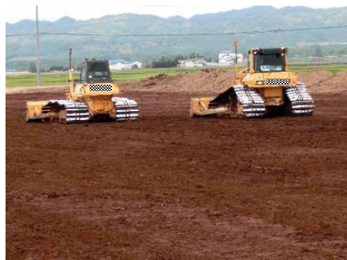
排水性などの土壌物理性を悪化しないように、適切な土壌水分時に大区画化施工している圃場
