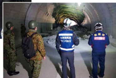
令和6年1月 令和6年能登半島地震における地盤 被災状況の報道対応、自衛隊とのトンネル被災調査 （のべ285人・日派遣）
