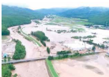
石狩川水系空知川堤防の決壊
