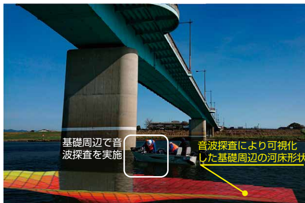
予防保全型メンテナンス技術の試行情例 (基礎洗掘の状態を把握するための水中部の可視化技術)
