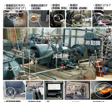
ポンプ設備の状態監視モニタリングシステム
