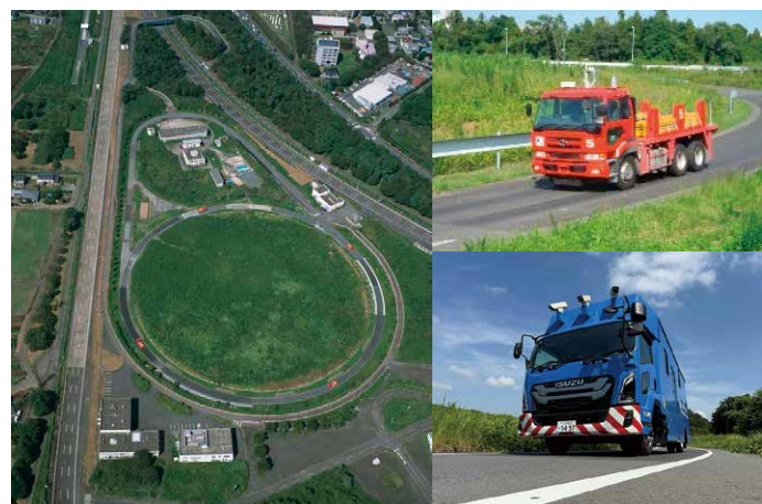
舗装の促進载荷実験と評価試験装置
