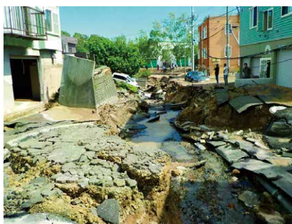
液状化による住宅地の被害
