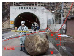
平成29年3月28日に発生した落石災害
