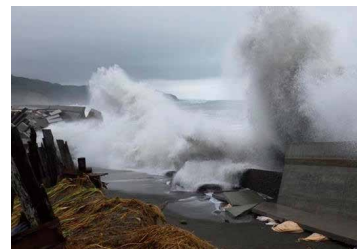
高波による海岸護岸の被災
