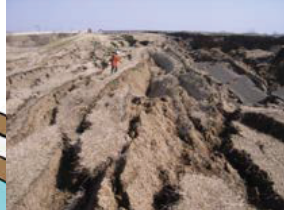
河川堤防の大規模変状と洪水への緊急対応
