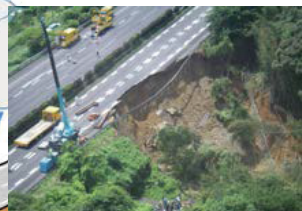
盛土崩壊による通行への甚大な影響
