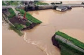
パイピングによる 破堤
