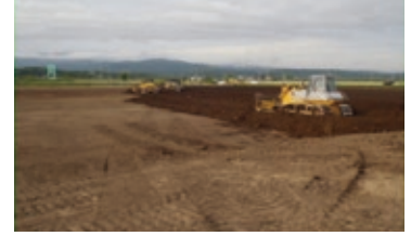
大区画圃場整備の工事状況： 土壌診断に基づく施工機械選 定・施工適期の判定が求めら れています。
