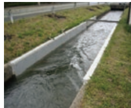
用水路補修の事例
