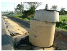
液状化による下水道被害の調査
