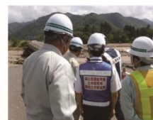
平成28年台風第10号等の豪雨災害における北海道日高町の橋梁や盛土の被災現場にて
