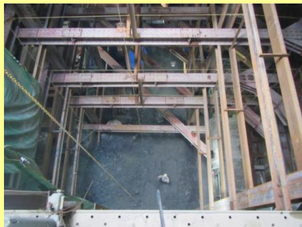
■掘削状況（GL-約20mまで）
