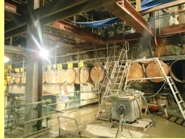
■パイプルーフ施工状況
