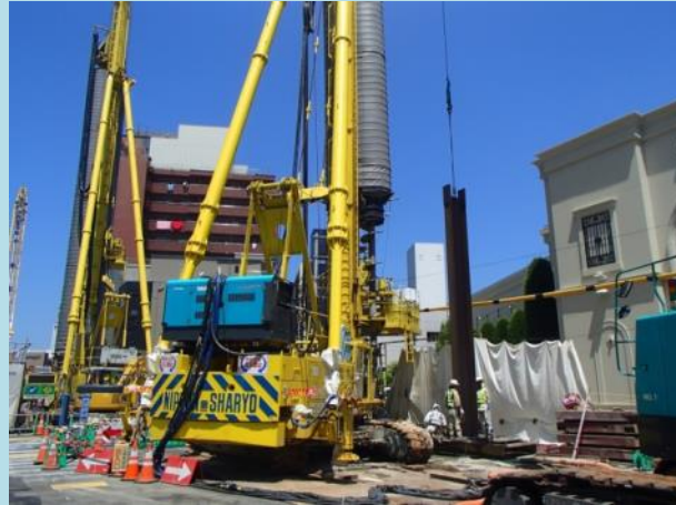
■土留工打設状況
