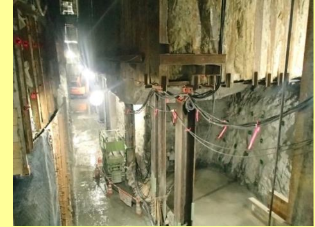
■アンダーピニング施工状況
