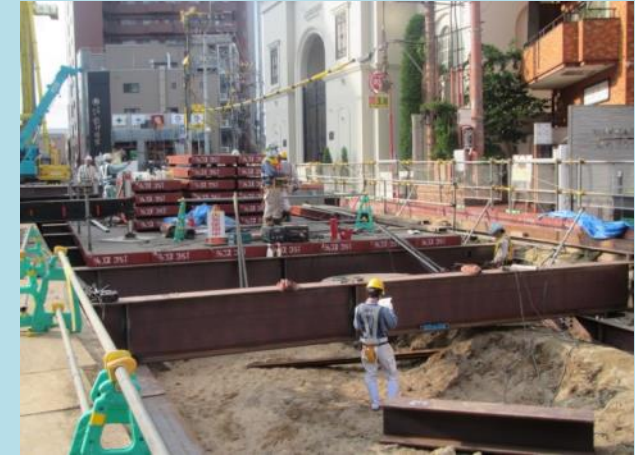
■路面覆工設置状況
