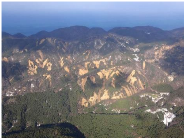
町野町鈴屋川流域等の斜面崩壊
