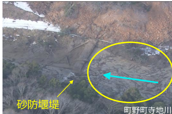
砂防堰堤上流の土砂・流木の堆積
